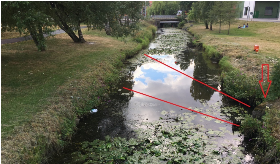
Foto 3. Dagvattenrör (röd pil) mynnar i Kvillebäcken. I rörets riktning förekom ingen knölnate, medan den förekom mycket rikligt både uppströms som nedströms mynningen.
