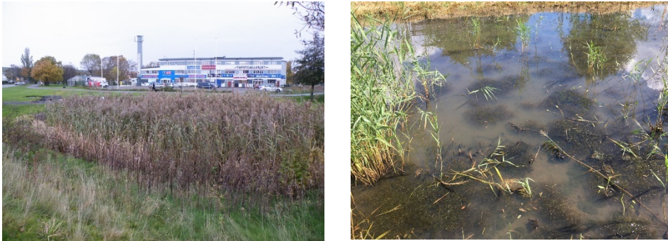
Foto 1 och 2. Dammen 2011 och samma damm 2018.
